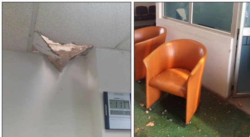
Fotografías No. 8 y No. 9 - Daños en techos y ventanas de oficinas
